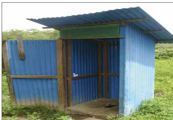
Foto 10. Construcción de letrinas funcionales en las fincas de los agricultores que permite una adecuada sanidad.
